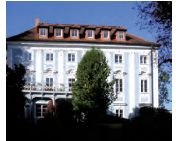
Schloss Lichtenegg, Oberösterreich im heutigen Zustand, nach den Zerstörungen des 2. Weltkrieges renoviert
